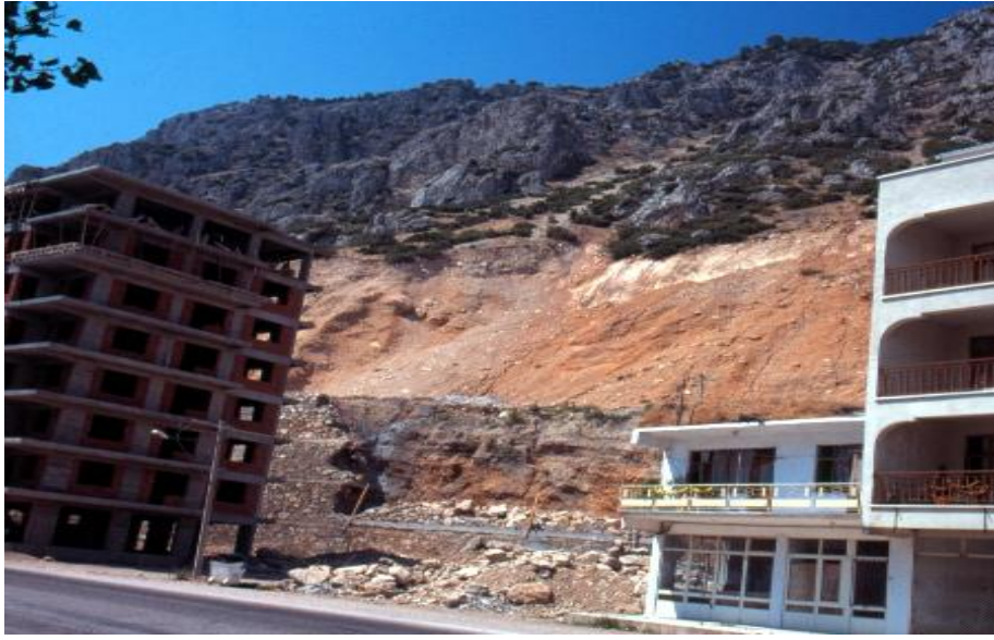
Foto-1. Eğridir Sivritepe eteğindeki birikinti konisinin ortadan kaldırılmasıyla oluşturulan konut alanında, daha binaların karkaslarının yapımı sırasında, Sivri Tepe'den taş düşmesi sonucu ihata duvarının yıkılması.
